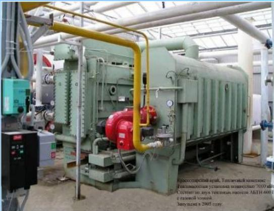
Комплекс **абсорбционных бромисто-литиевых тепловых насосов 7 МВт** (**ИТ СО РАН, Теплосибмаш**)
