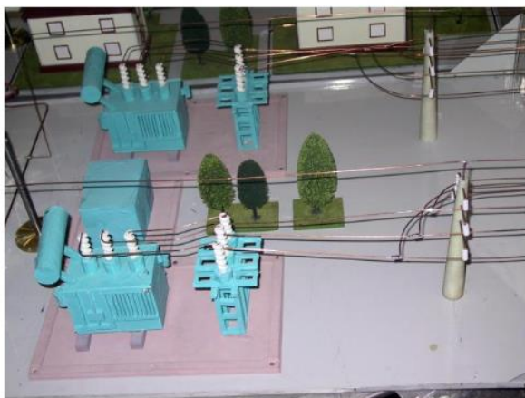
Figure 5 Рис. 5. Модель ОРУ подстанции
